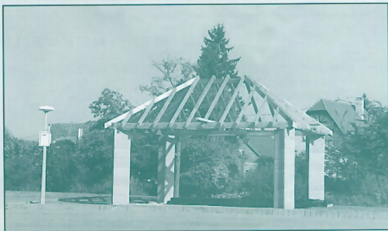
Ci-dessus : l'abri en cours de réalisation
