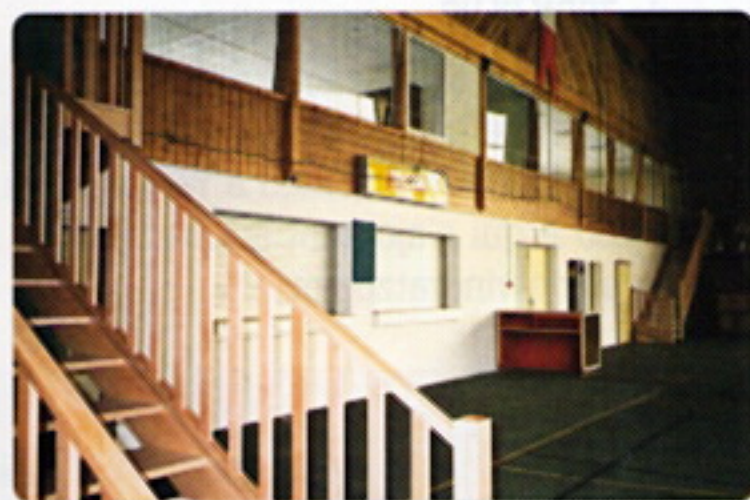
Escaliers de secours des 2 salles
