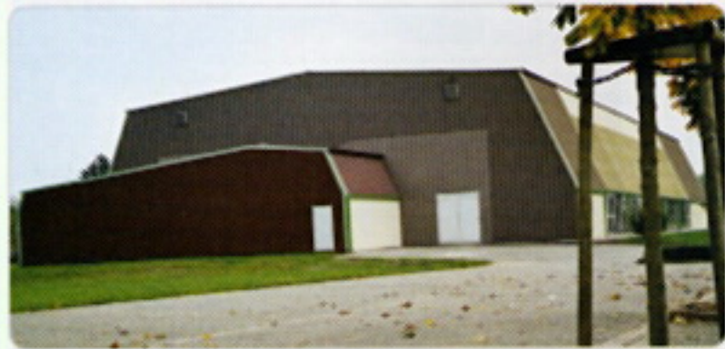
Vue extérieure du local de rangement
