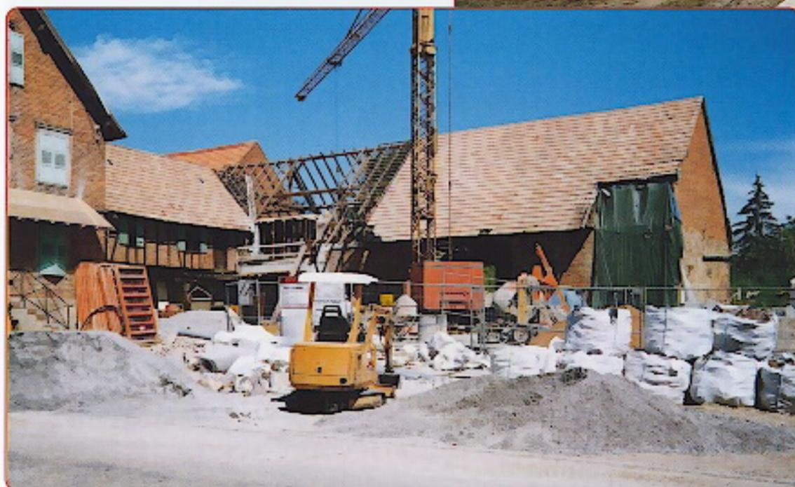
Début effectif des travaux après la démolition du bâtiment annexe perpendiculaire à la rue. L'installation de la grue va permettre de démarrer le gros œuvre et les charpentiers ont commencé à découvrir le toit.
