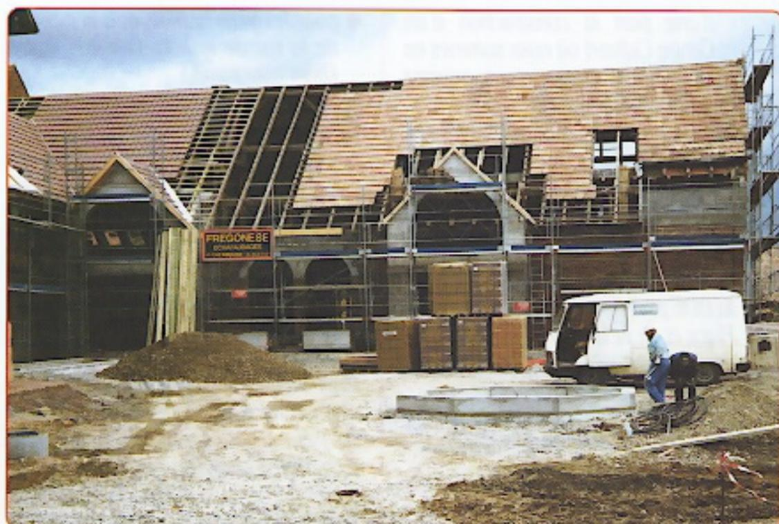
Quelques semaines ont passé : on aperçoit déjà les pignons qui surplombent les deux entrées ainsi que les nouvelles fenêtres en forme d'arche. La pose des nouvelles tuiles se fait au rythme du transfert des anciennes (celles en bon état) sur la partie arrière de la toiture. La place prend également forme et l'on devine déjà l'emplacement de la future fontaine.
