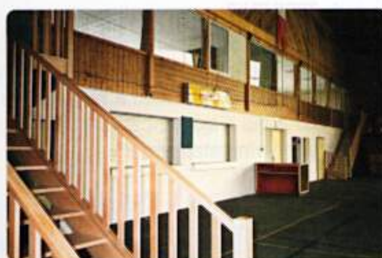
Escaliers de secours des 2 salles
