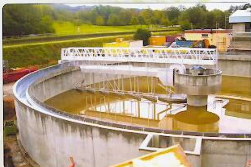
En cours de chantier du bassin appelé «clarificateur» d'un diamètre de 31 m
