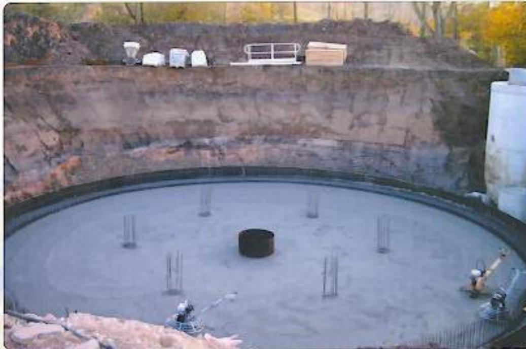
*Le radier en béton (13 tonnes de ferrailage et 110 m<sup>2</sup> de béton)*
