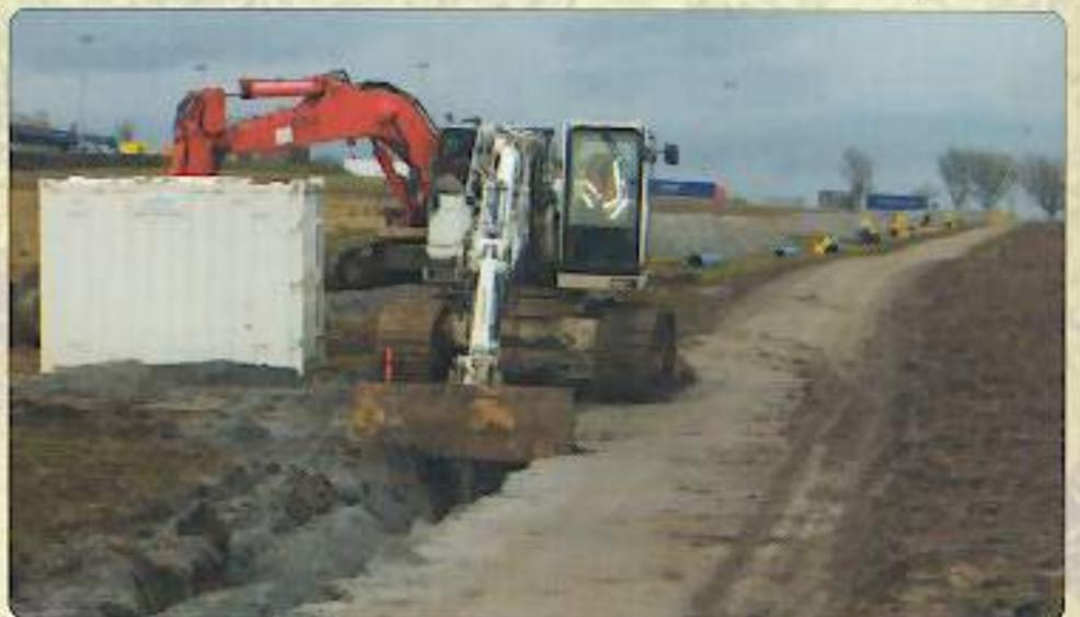
*Le Syndicat des Eaux (SDEA) profite des travaux (giratoire et zones) pour mettre en place une conduite d'alimentation en eau potable. Celle-ci a pour but de sécuriser l'alimentation des bâtiments du péage de l'autoroute au cas où un incident serait détecté sur la conduite actuelle. Dans le même but, elle desservira Minversheim, Mommenheim et Schwindratzheim, avant de bifurquer sur Hochfelden pour rejoindre le château d'eau de Scherlenheim.*
