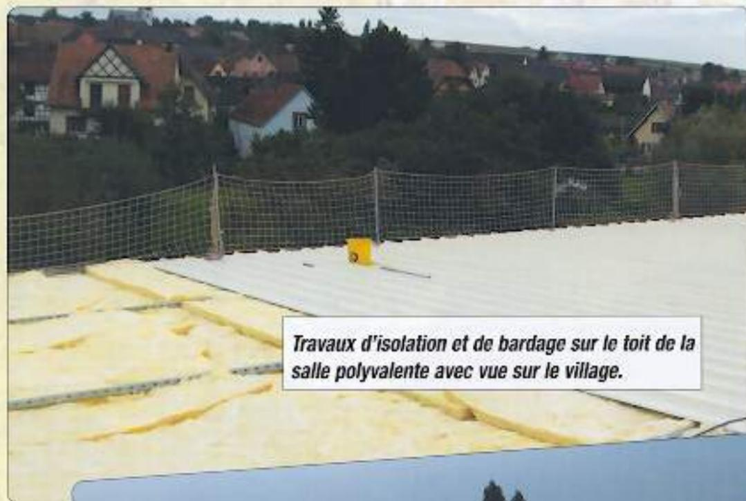
Travaux d'isolation et de bardage sur le toit de la salle polyvalente avec vue sur le village.
