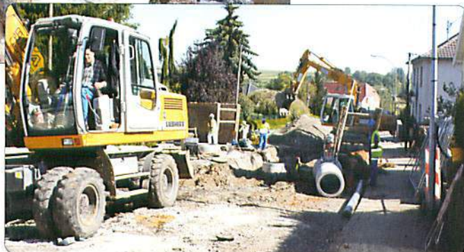
Travaux d'assainissement route de Pfaffenhoffen à Hochfelden
