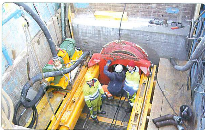
Mise en place d'un micro-tunnelier en vue de réaliser un fonçage permettant la pose du réseau d'assainissement rue de la Forêt à Hochfelden
