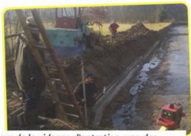
Lors de la vidange d'entretien, une des berges était en mauvais état. La première tranche a été réparée au printemps avant la remise en eaux.
