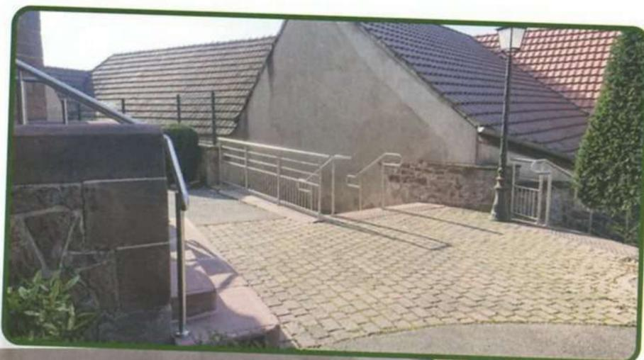
L'entreprise Rauscher a réalisé les travaux de maçonnerie, taille, réfection, gravure et pose des marches tandis que l'entreprise locale Will a conçu et mis en place la partie ferronnerie (ou devrait-on dire « inoxerie »).
